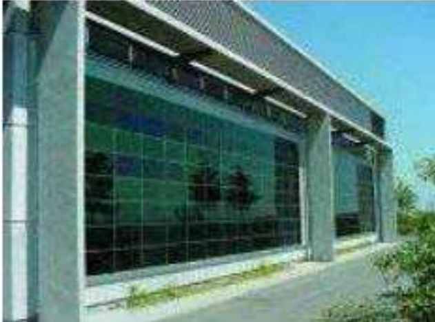
Edifício industrial com módulos ATF em Flörsheim, Alemanha
