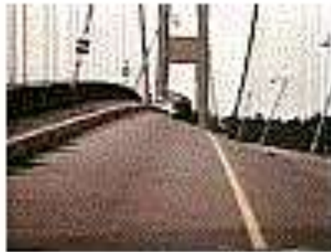
Ponte de Tacoma vibrando no modo torsional.
